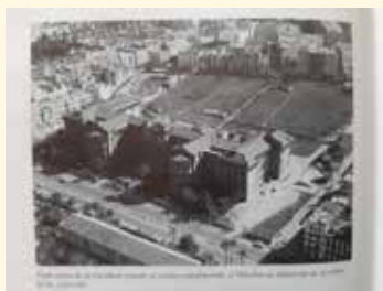
Construcción del Pabellón de Industrias en el recinto de la Facultad de Veterinaria en su antigua ubicación de la Avenida de Medina Azahara (Rodero, 2002)
